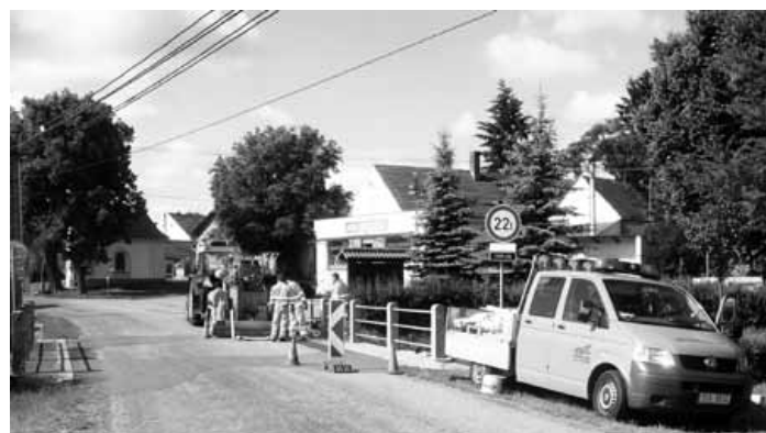
Oprava mostu přes Rojický potok - SÚS Strakonice
