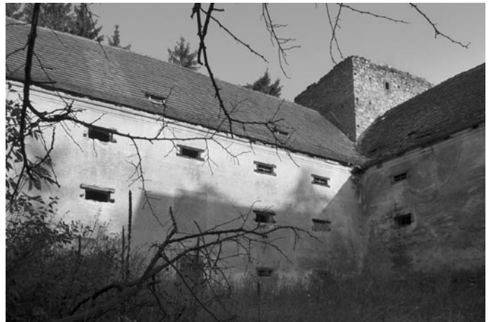
Pohled na jádro tvrze v Buzicích
