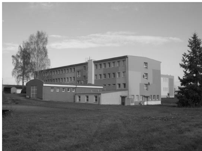
Komplex budov domova a školy po provedeném zateplení a výměně oken.
