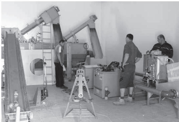
Modernizace ČOV bude dokončena v srpnu
