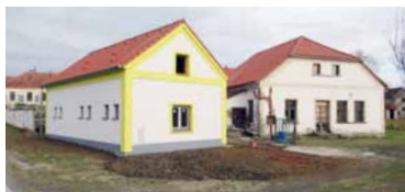
Výstavba zázemí pro sportoviště
