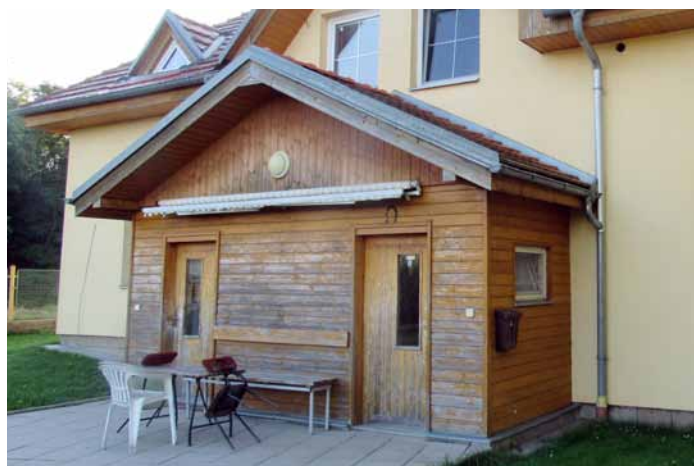
čp. 77 před renovací nátěrů
