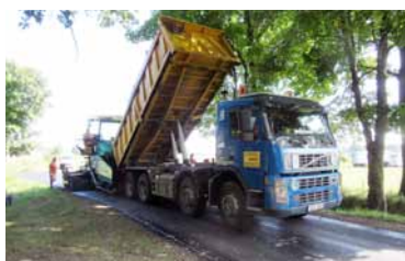
Pokládka nového asfaltového povrchu Velká Turná – Milavy
