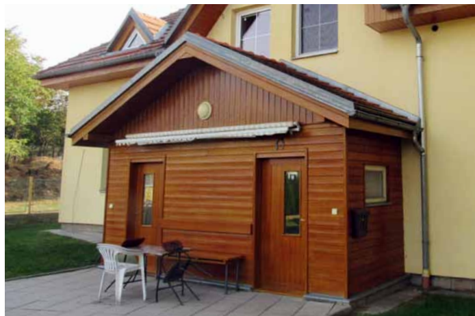
renovace nátěrů čp. 77
