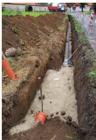
Pokládání vodovodu a kanalizace
