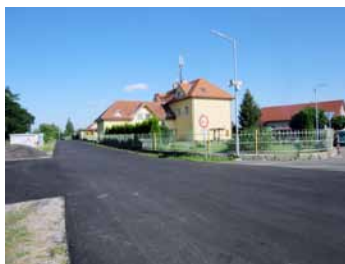
Opravená komunikace u obecního úřadu
