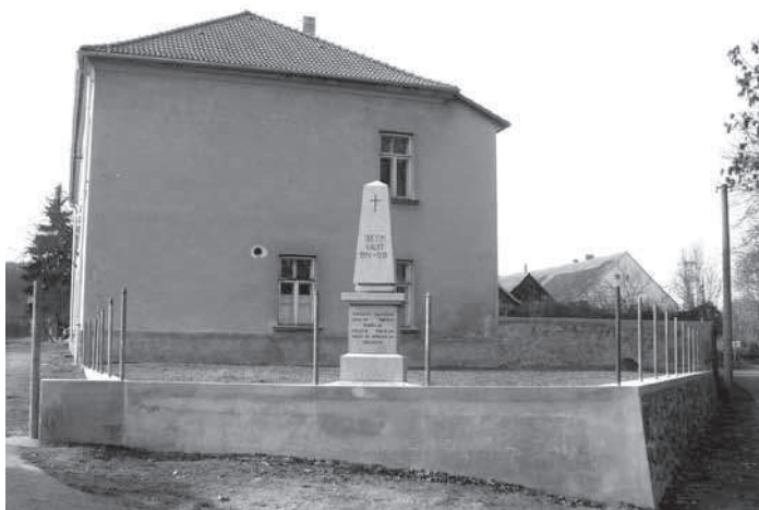
Oprava opěrné zdi a oplocení - škola Velká Turná
