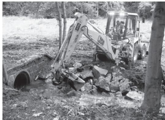
Oprava břehů koryta Rojického potoka-po povodních 2013
